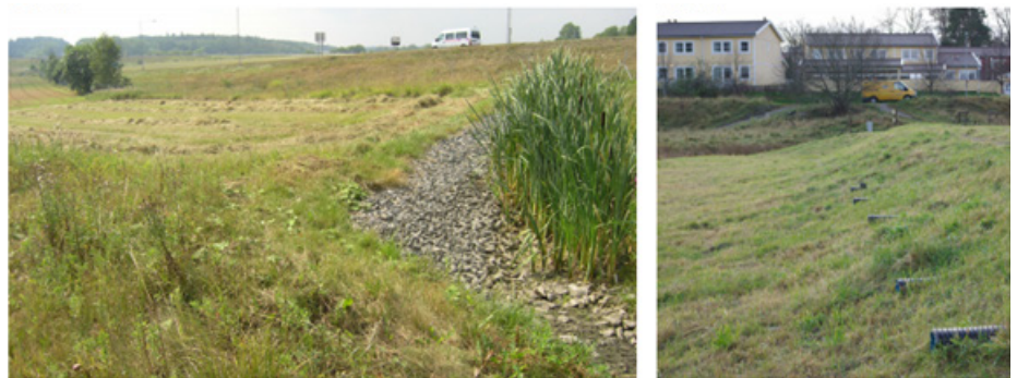
Till vänster en översilningsyta där vatten fördelas över ytan via ett makadamlager. I anläggningen till höger leds vatten till översilningsytan från ett bostadsområde med hjälp av ett system av rörledningar.
