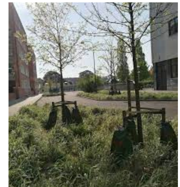
Nedsänkt växtbädd i grönytor närmast byggnaden
