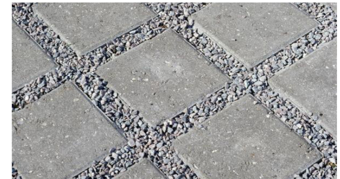
Grusarmering på körytor på gästparkeringen
