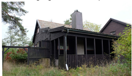
Bild 6 Huvudbyggnaden. Vy åt öster.
