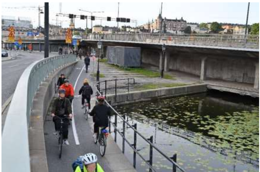
Bild 8. Cykelbana mot Gamla stans tunnelbana
