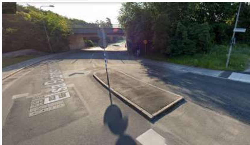
Figur 3. Hastighetssäkring vid övergångsställe och cykelpassage i väster.
