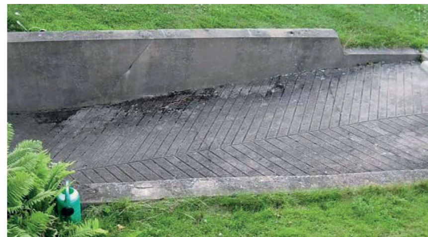
Exempelbild som visar öppen nedfart i betong.
