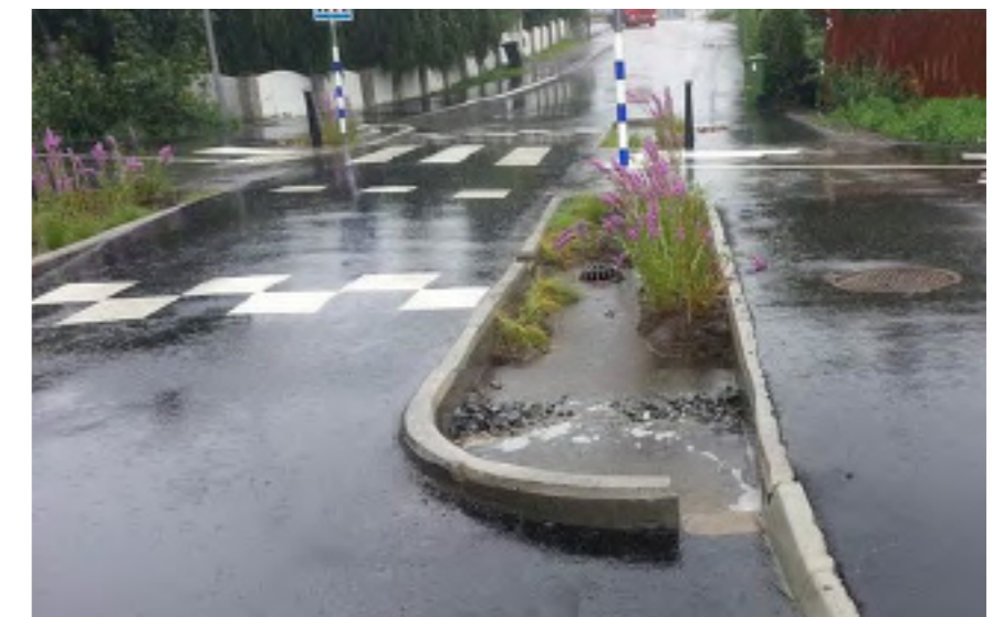
Exempel på välfungerade raingarden för lokalt omhändertagande av dagvatten i vägmiljö, Öringevägen i Tyresö.
