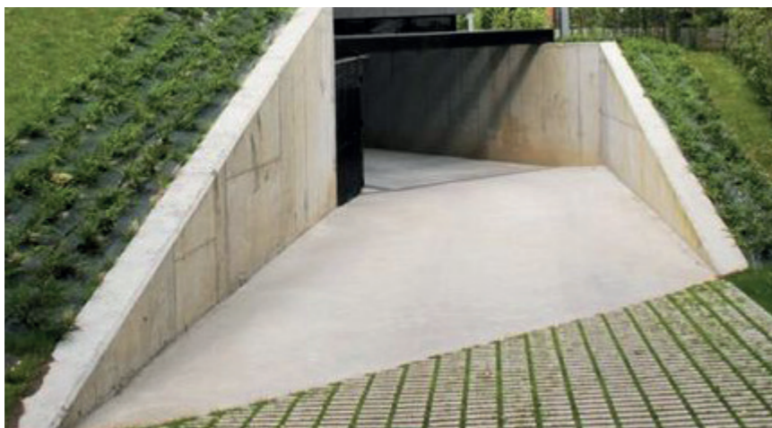
Exempelbild som visar öppen nedfart i betong.
