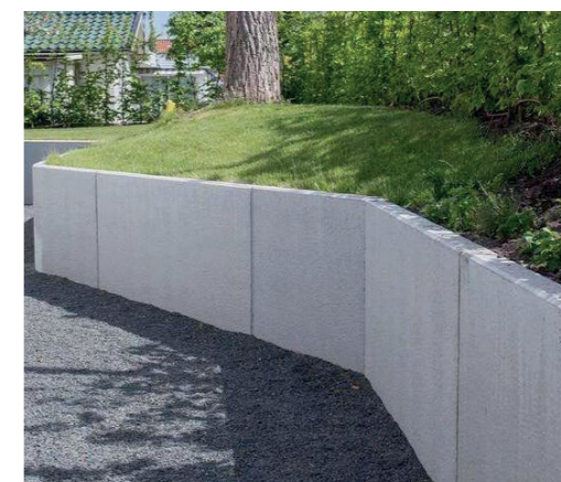
Låga stödmurar mellan uteplats och golfbana
