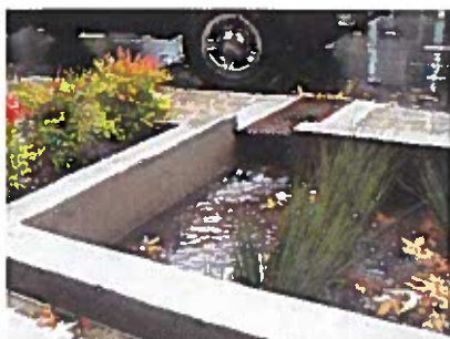
Synlig dagvattenhantering ökar förståelsen för vattnets kretslopp. Vattenväxter såsom tåg- och starrarter bidrar till att rena vattnet.
