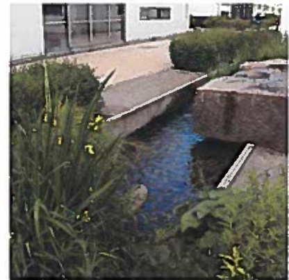
Synlig dagvattenhantering med renande vattenväxter, bl. a. iris. Bild från Västra Hamnen, Malmö
