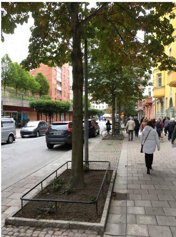
Figur 22. Exempel på träd i skelettjord där inloppet av dagvatten sker via brunnen till höger om trädet.
