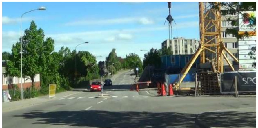
Figur 4, Bild före anläggandet av dynamiska farthinder på Vårholmsbackarna.
