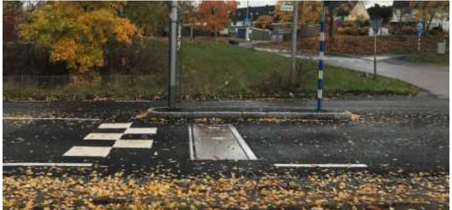
Figur 5, Närbild på dynamiskt farthinder på Sörgårdsvägen.
