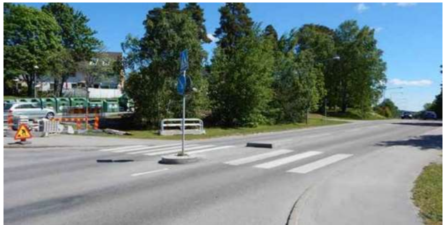
Figur 3, Bild före anläggandet av dynamiska farthinder på Sörgårdsvägen.
