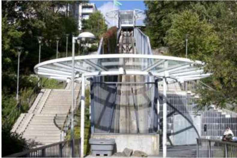
Bild 3. Bild redovisande befintlig bergbanas dalstation sedd från Skärholmens centrum.
