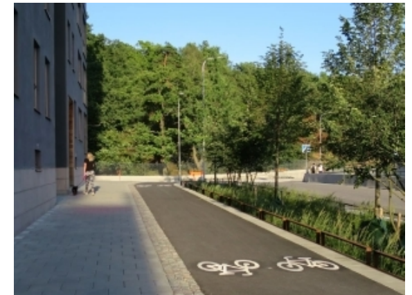
Öster om korsningen med Njukärrsvägen utförs gångbanor med betongplattor.
