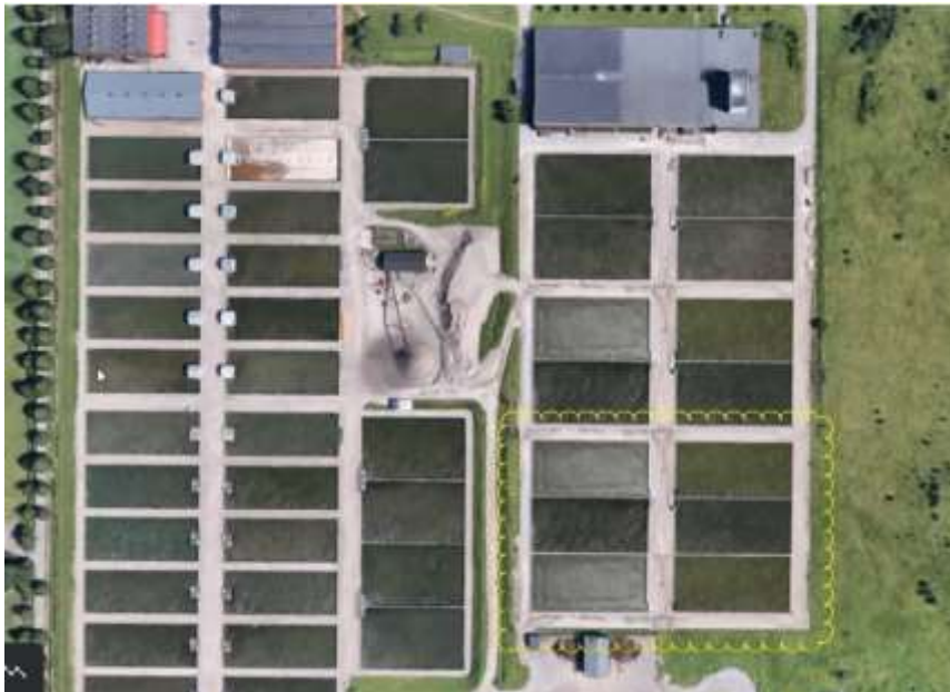
Flygfoto över Norsborg Vattenverk, höger i bild visas den tänkta placeringen av sex stycken nya långsamfiltren på östra verket.
