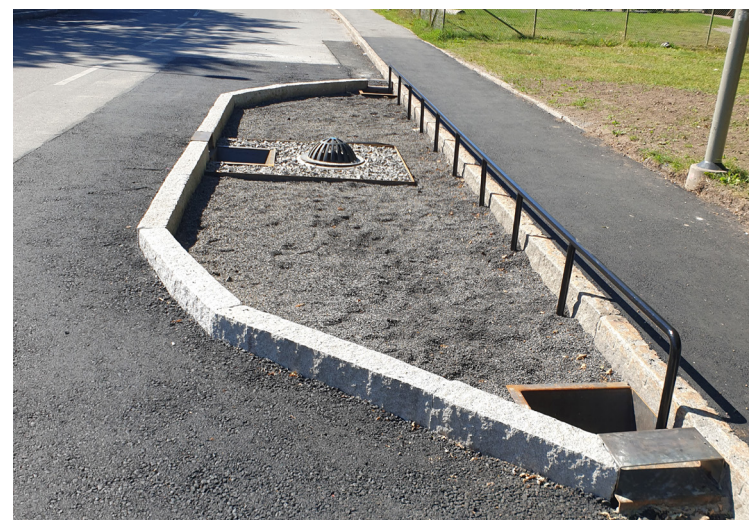
Exempel på "regnbäddsöra" med inlopp för vatten i båda ändar samt i mitten. I förslaget planteras buskar i ytan.
