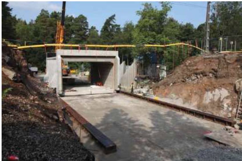
Bild 3. Exempelbild där lansering av en förtillverkad brokonstruktion pågår (Bråvallavägen 2014).
