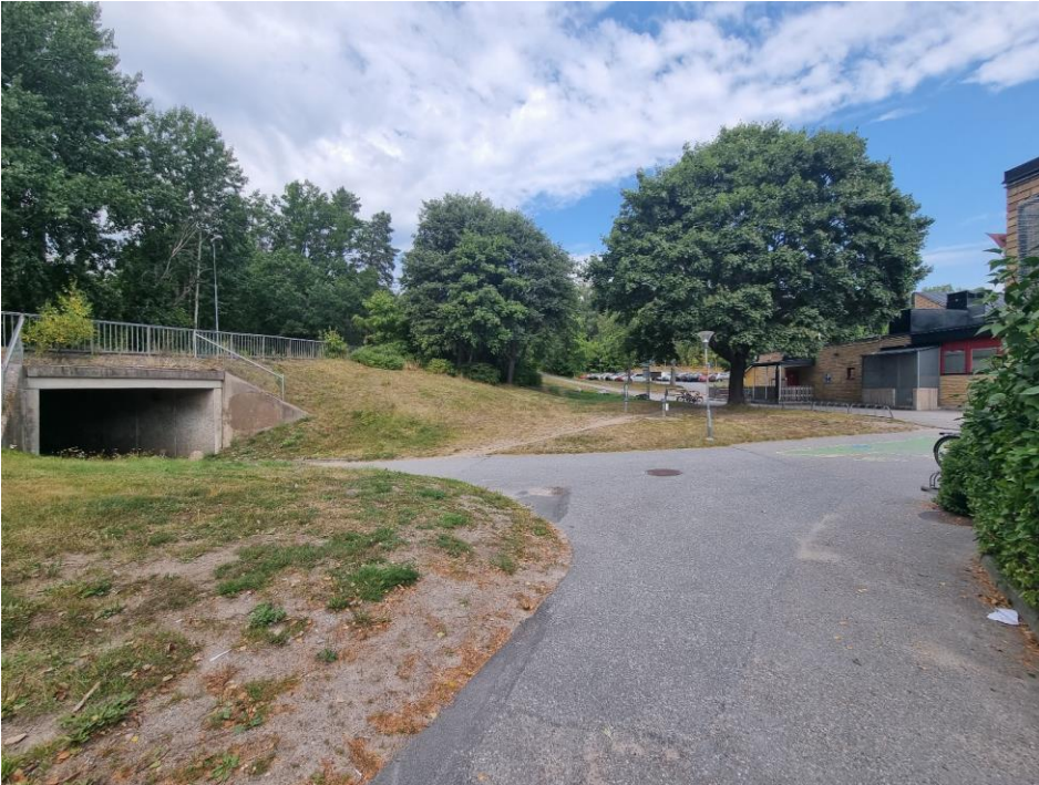
Figur C. Befintlig servispunkt för vatten, spillvatten och dagvatten återfinns vid den norra gångtunneln under Njupkärrsvägen. Området utgör en lågpunkt där vatten ansamlas vid extrema regn/skyfall.
