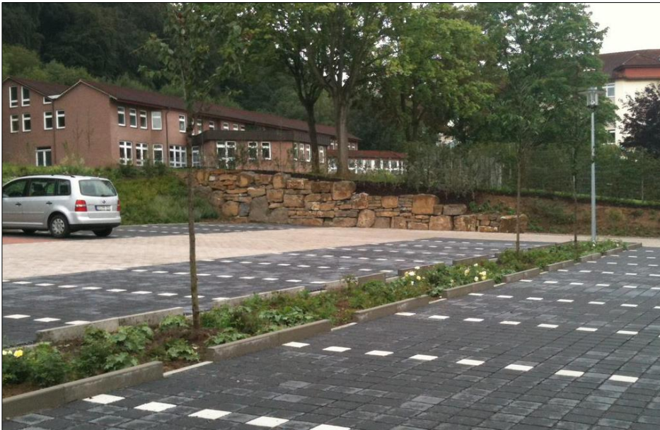
Figur 16. Exempel på regnbäddar i parkeringsmiljö. Foto: Sweco
