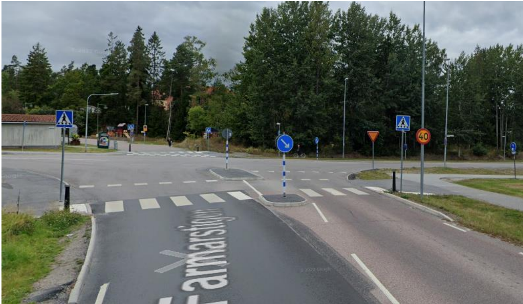
Figur 14 Övergångsställe med mittrefug över Farmarstigen (Bild från Google maps, bildinsamling september 2022).
