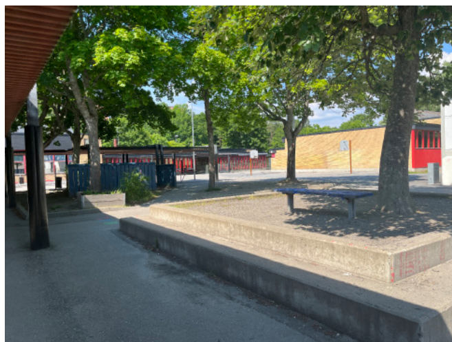
Planteringar i gjuten betong är ett nyare inslag på skolgården.
