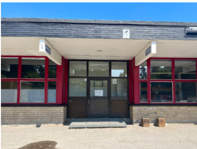
Klassrum på vardera sida om separat entré.
