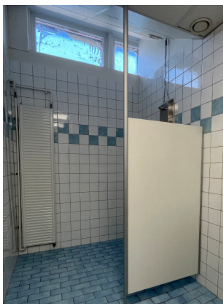
Omklädningsrummen delade tidigare duschrum men en skiljevägg har satts upp för att ge varje omklädningsrum ett separat duschrum.
