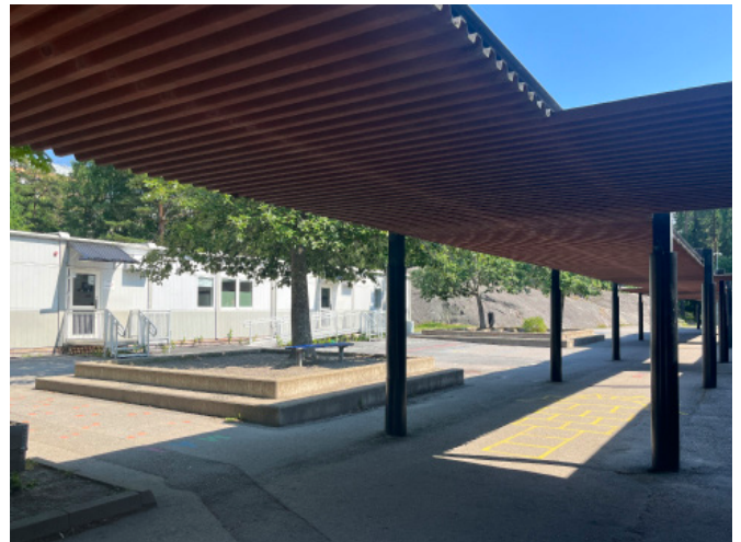
Regnskydd i korrugerad plåt som binder ihop huvudbyggnaden med matsalsbyggnaden. I bakgrunden nya planteringar på skolgården.
