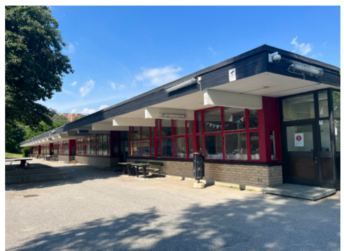
Fasaden domineras av de stora fönsterpartierna och det tilltagna taksprånget.
