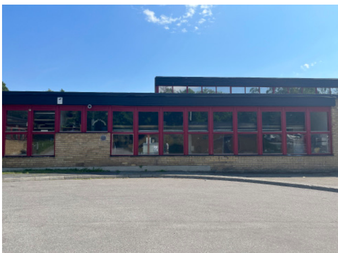
Matsalsbyggnadens norra fasad, från köket, exemplifierar den varierande fönstersättningen.
