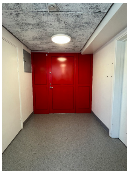
Ny dörr i korridoren skärmar av omklädningsrum från administrativa lokaler.
