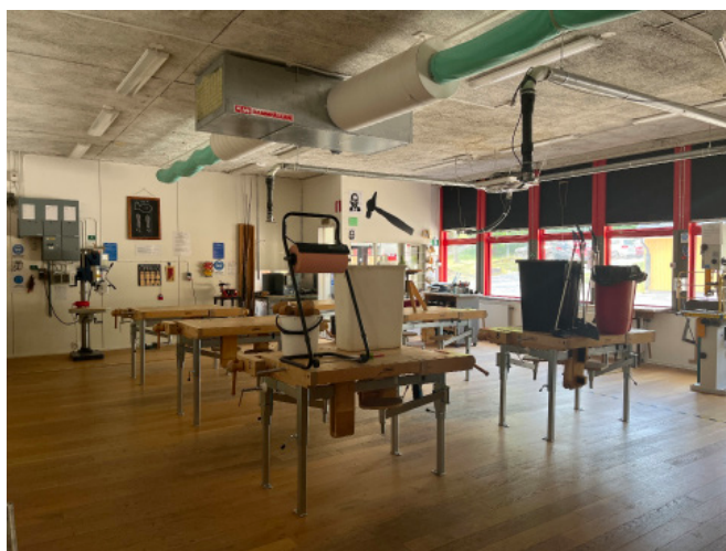
I träslöjdssalen är de ursprungliga träullsplattorna synliga i taket.
