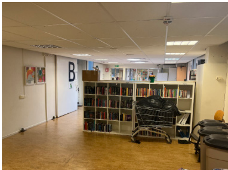
Mediateket som fått nytt undertak och ny golvbeläggning.
