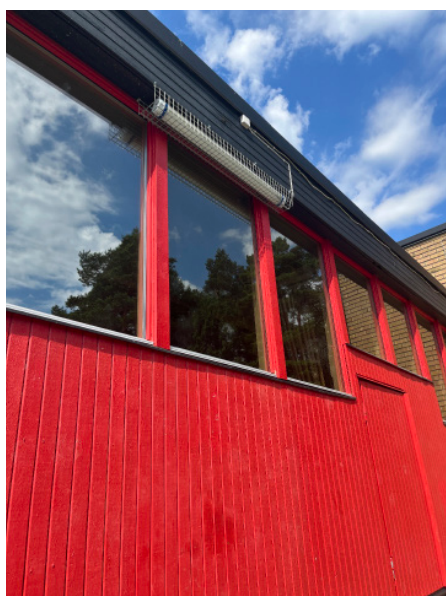
Mot söder har fasaden försetts med rödmålade stående paneler.
