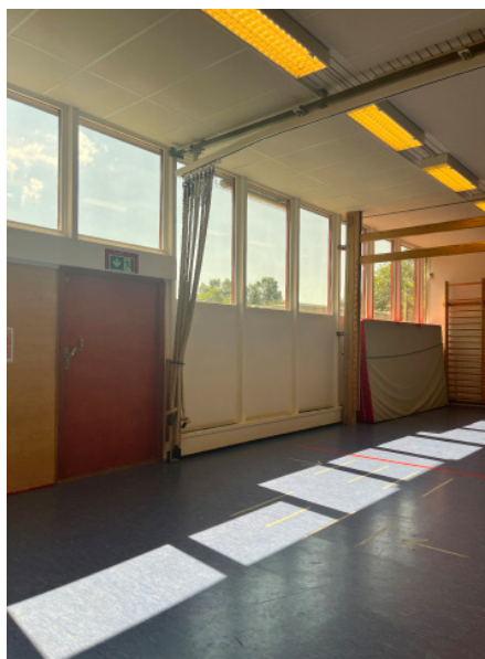
Den mindre gymnastiksalen med fönster ut åt sydost.
