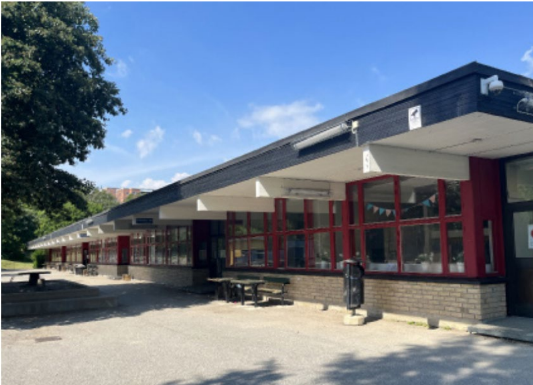
Figur 25. Fotografi på huvudbyggnaden sett från sydväst (AIX arkitekter).
