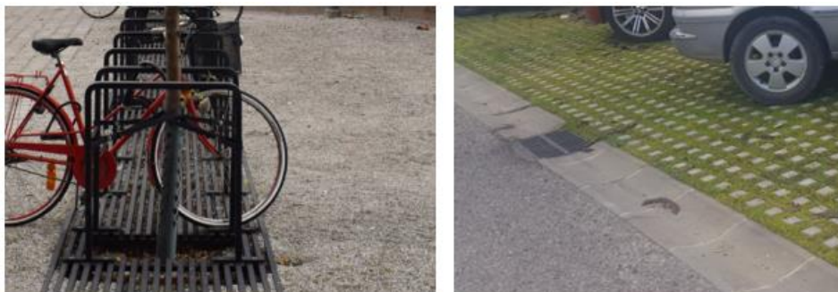
Figur 17. Exempel på genomsläppliga beläggningar på cykel- och parkeringsytor. Foto t.v.: VA-syd, foto t.h.: Sweco
