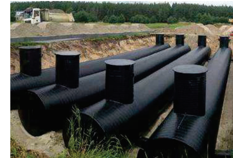
Referensbild rörmagasin i betong. Magasinet utgörs av parallella ledningar. (Bildkälla: Uponor)
