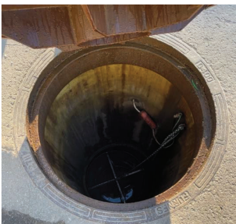
Figur 15. Oljeavskiljaren på området vänstra bilden (foto: Bjerking, 2022-10-11). Den högra bilden visar en typskiss från MIRI OAM 21 produktblad.
