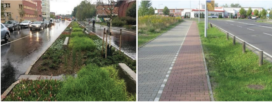
Figur 13. Till vänster: BGG-system vid strandbogatan i Uppsala. Systemets primära funktion är rening av dagvattnet från gaturummet. Vid ett skyfall kommer vattnet till stor del att avrinna via körbanan till Fyrisån. Till höger: Ett grönt svackdiken som kan avleda stora mängder vatten i diket. Foto: WRS.
