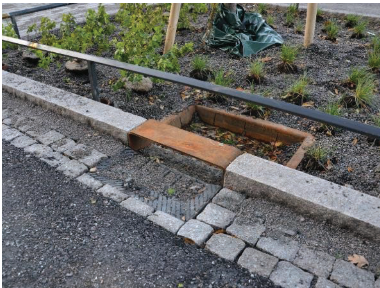
Figur 18. Intag från körbana genom kantsten med öppet sandfång. Foto: Edge.
