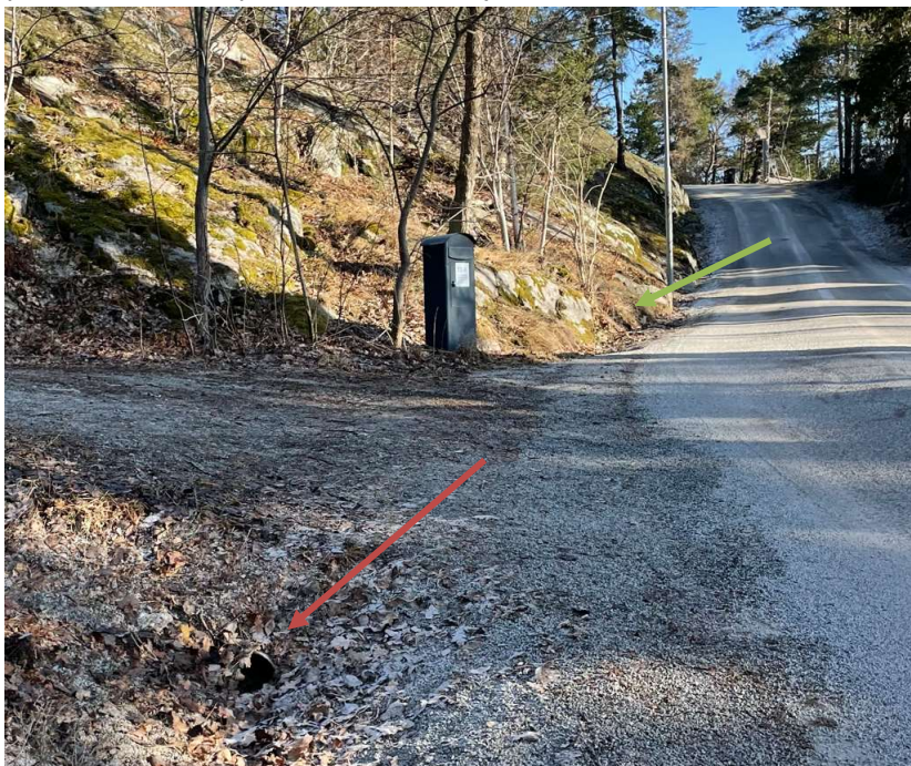
Figur 8. Foto från Backsippevägen 13A, diket från gemensamhetsanläggning ligger i vägens vänstra sida, se grön pil. Anslutning till kommunens dikey sker vid infarten till 13A, rör under infarten är markerat med röd pil (foto: Viveka Lidström 2024-03-12)
