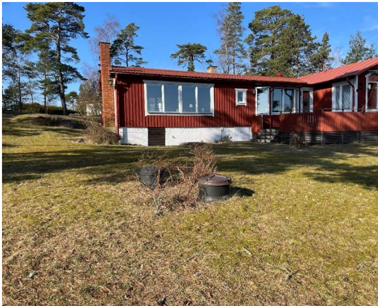
Figur 22 Uppfylld yta vid huvudbyggnaden, i förgrunden syns fördelningsbrunnar för infiltrationsanläggning dit takavvattning från stuprör 4,5,6 och 7 leds. (foto: Viveka Lidström 2024-03-12)
