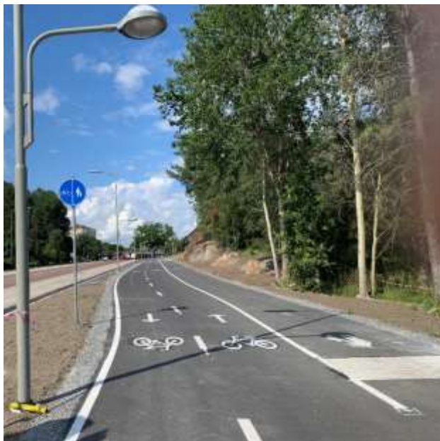
Figur 2 Breddad gång- och cykelbana, i riktning mot Hökarängen
