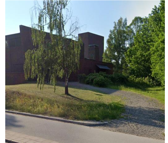
Förbindelseväg i grus före ombyggnaden
