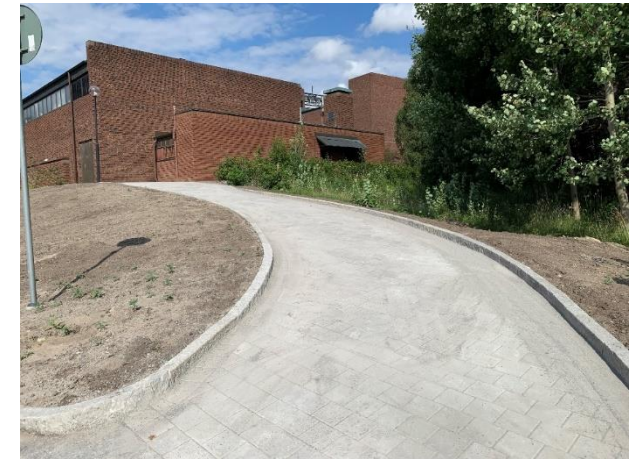
Plattlagd förbindelseväg från Örbyleden upp mot kyrkan efter ombyggnad
