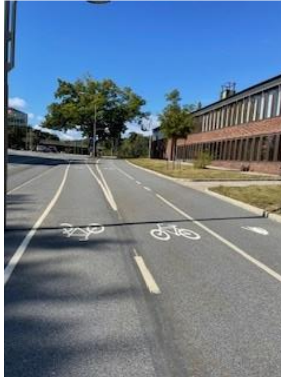
Anslutningen efter ombyggnaden
