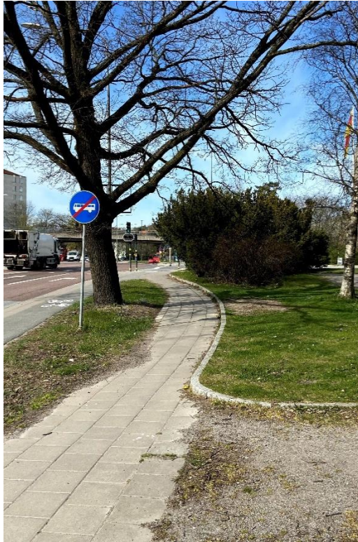
Anslutning från gångbanan mot kyrkan före ombyggnaden
