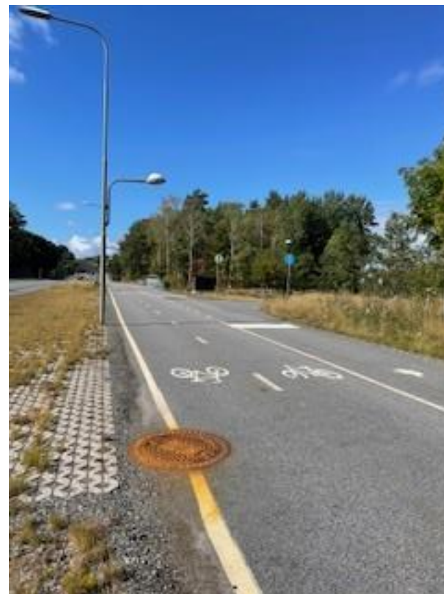
Efter ombyggnaden, ny gång- och cykelbana och ny förbindelse ner mot Gubbängsfältet.
