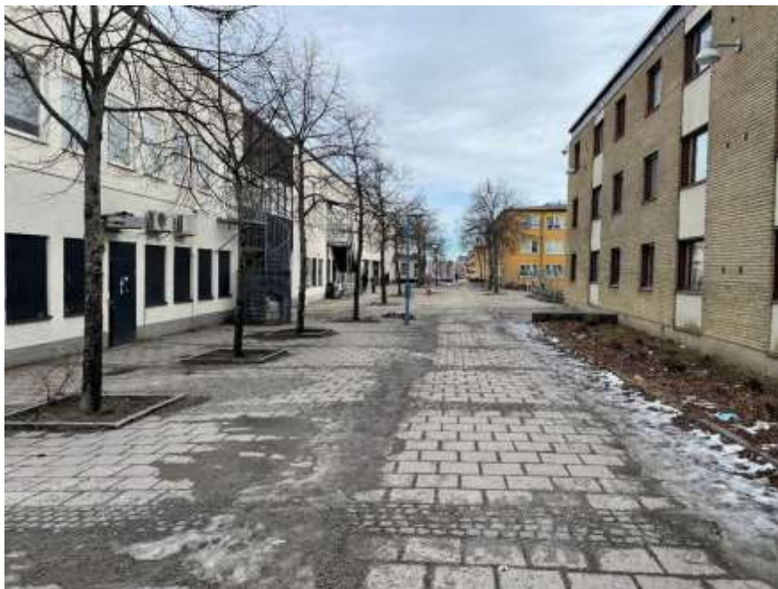
Bild 2 Södra Rinkebygången, före åtgärd
