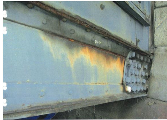
20 - Båge - Stål - Korrosion 2013-11-25
