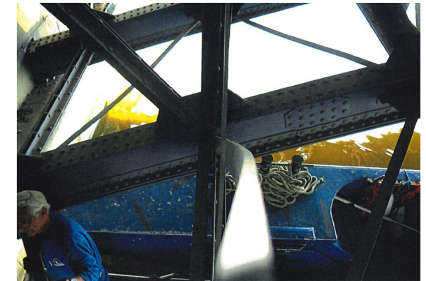
46 - Sekundärbalk - Stål - Deformation 2013-11-25
