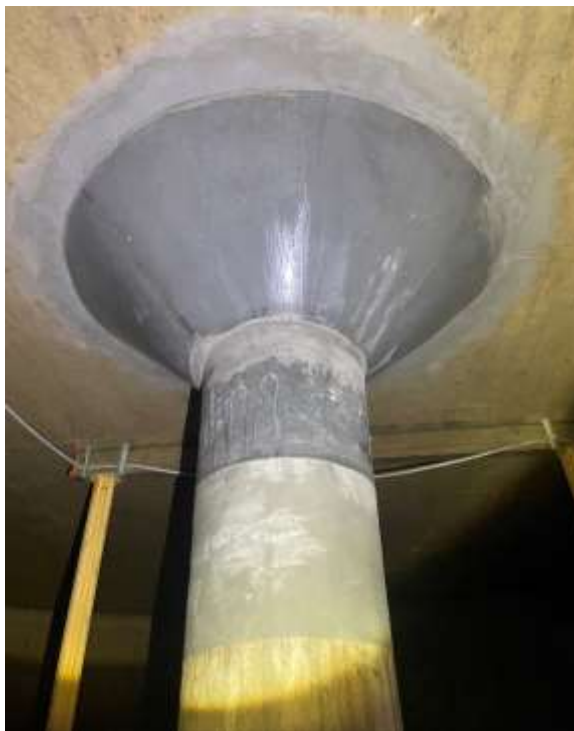
Bild 4: Betongpelare i krigsbranddamm efter åtgärd
