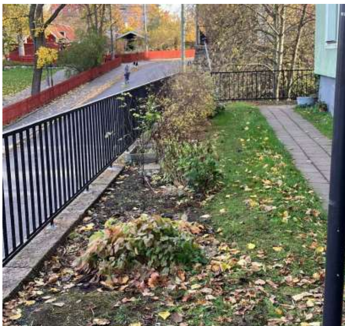
Bild 6: Räck Högalidsgatan efter renovering
