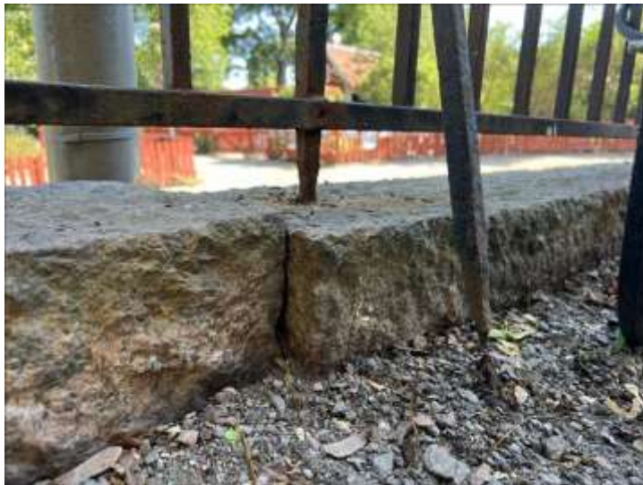
Bild 5: Räck Högalidsgatan före renovering
