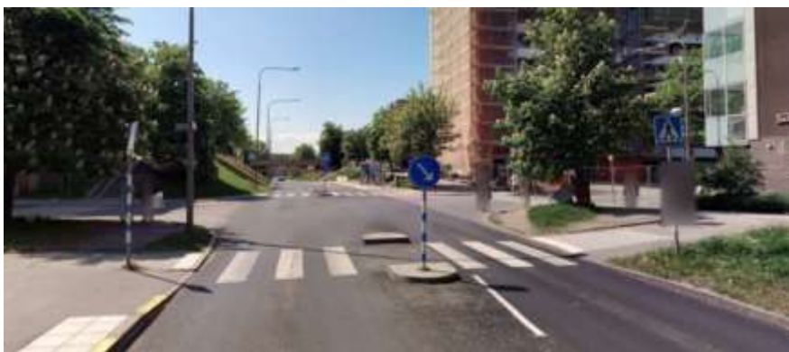
Figur 2. Tenstastråket vid korsning med Tensta Allé, innan ombyggnation. (Trafikkontoret, 2021)
