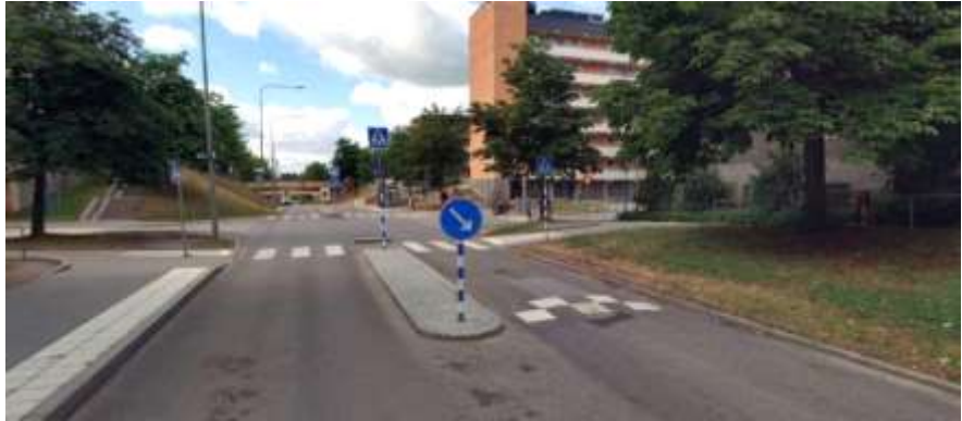
Figur 3. Tenstastråket vid korsning med Tensta Allé, efter ombyggnation. Korsningen har kompletterats med väghyllor innan passage och förlängda refuger (Trafikkontoret, 2023)
