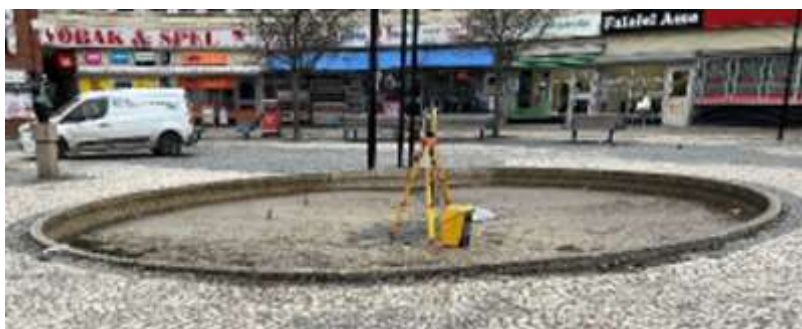
Bild 1. Fotografi som visar fontänbassäng innan renovering påbörjas.
