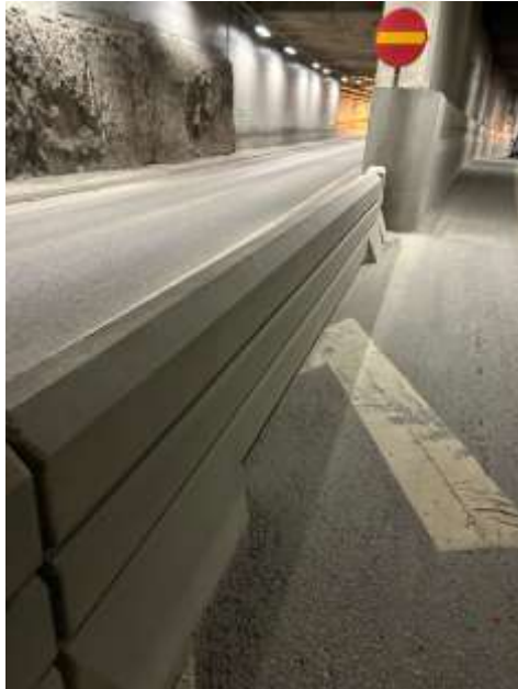
Bild 4. Fotografiet föreställer barriär mellan lokalgata till höger och huvudtunnelrör till vänster innan montage av bom.
