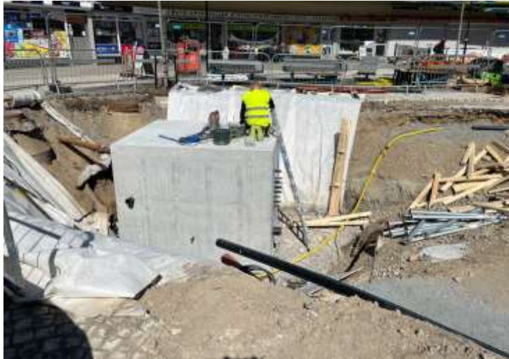
Bild 2. Fotografi som visar den platsgjutna nya pumpkammaren, fontänbassängen kommer byggas till höger i bild.
