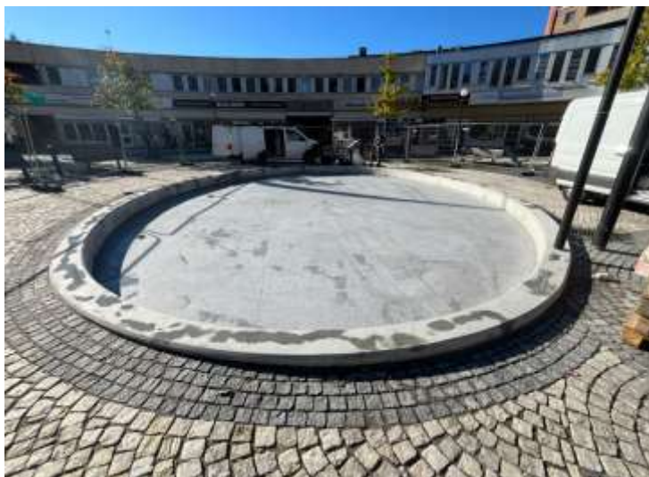
Bild 3. Fotografi som visar den färdiggjutna fontänbassängen och installationsarbeten som pågår längst bort i bild.
