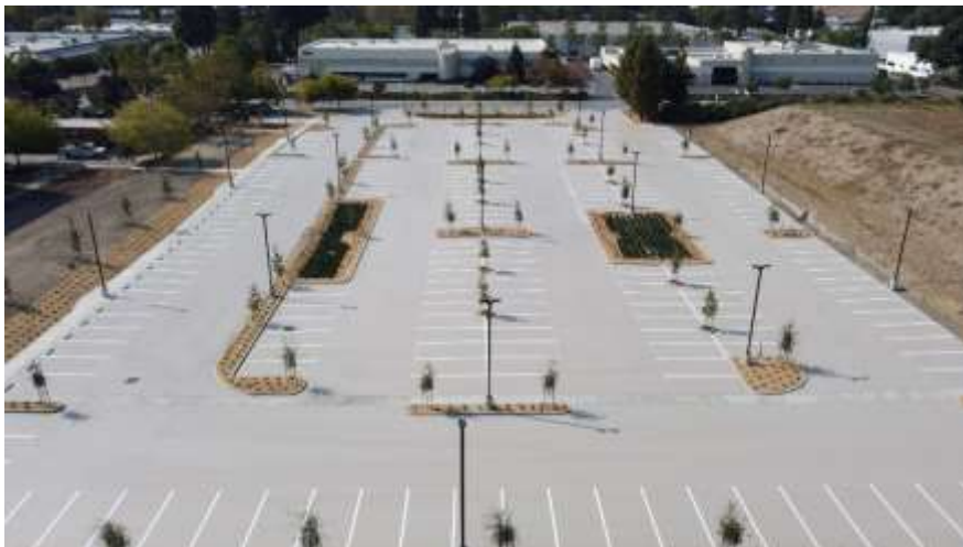
Bild av parkeringsyta belagd med CoolSeal, hämtad från företagets hemsida.
