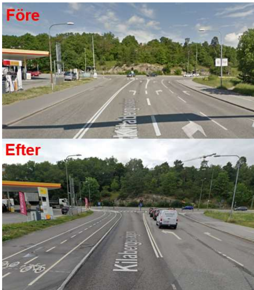
Figur 11. Bild som visar två foton av Kilabergsvägen, mot korsningen med Hägerstensvägen. Övre fotot är taget före och nedre fotot efter ombyggnaden. Fotona är tagna i nordlig riktning och visar hur ett högersvängkörfält på Kilabergsvägen tagits bort och hur gång- och cykelbanan breddats. (Källa: Google)
