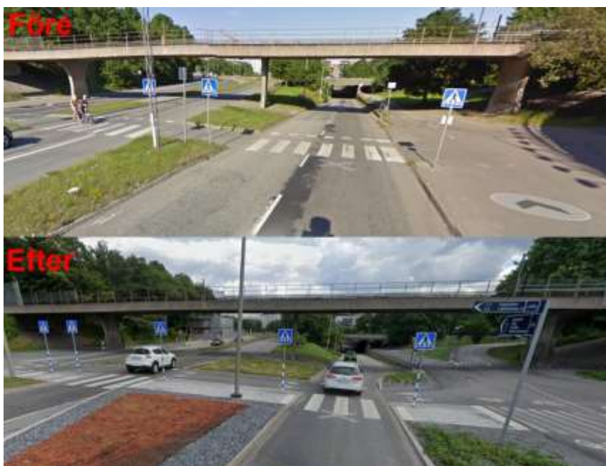
Figur 5. Bild som visar två foton av Hägerstensvägen i anslutningen mot Södertäljevägen, före och efter genomförda åtgärder. Övre fotot är taget före och nedre fotot efter ombyggnaden. Fotona är tagna i östlig riktning och visar hur gång- och cykelpassagen breddats och körbanan smalnats av. (Källa: Google)
