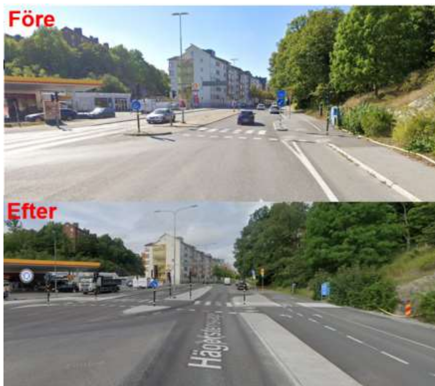
Figur 10. Bild som visar två foton av Hägerstensvägens norra sida, vid korsningen med Kilabergsvägen. Övre fotot är taget före och nedre fotot efter ombyggnaden. Fotona är tagna i västlig riktning och visar hur gång- och cykelbanan breddats och väntytorna utökats. (Källa: Google)
