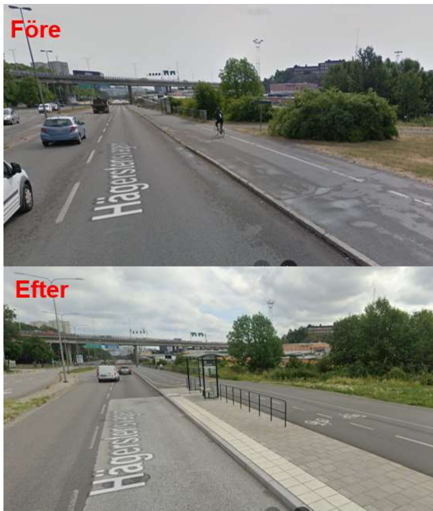
Figur 3. Bild som visar två foton av Hägerstensvägens södra sida före och efter genomförda åtgärder. Övre fotot är taget före och nedre fotot efter ombyggnaden. Fotona är tagna i östlig riktning och visar den ombyggda busshållplatsen och breddningen av gång- och cykelvägen. (Källa: Google)
