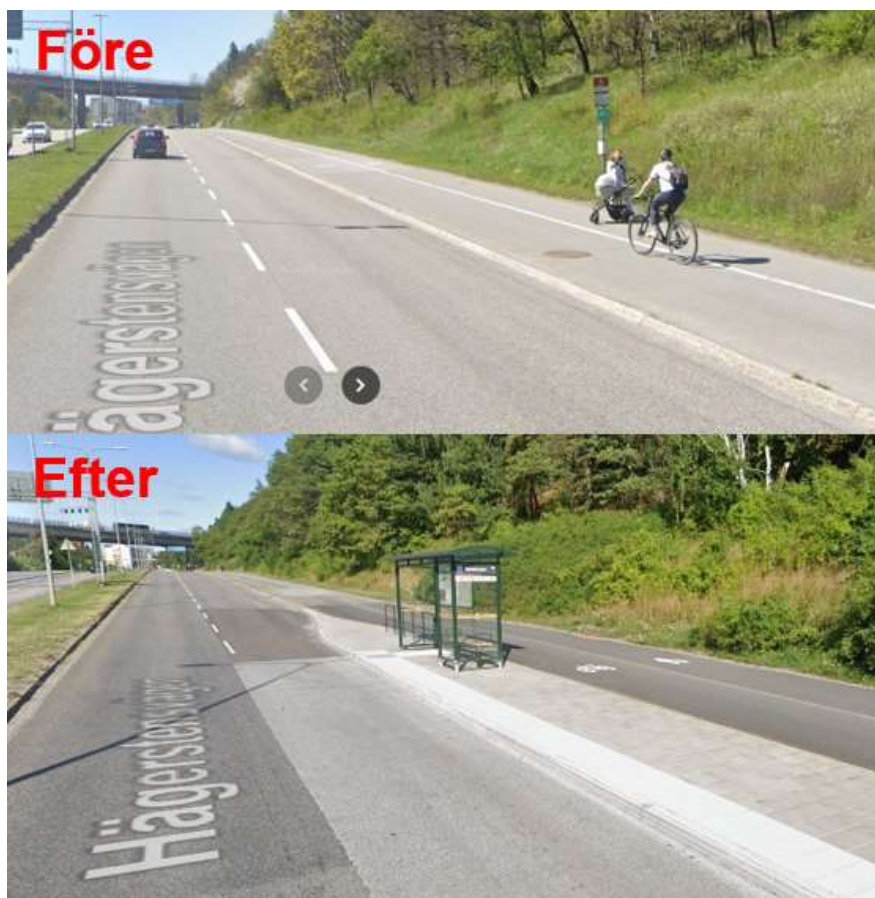
Figur 6. Bild som visar två foton av Hägerstensvägens norra sida före och efter åtgärderna. Övre bilden är taget före och nedre fotot efter ombyggnaden. Fotona är tagna i västlig riktning och visar hur busshållplatsen byggts om. (Källa: Google)
