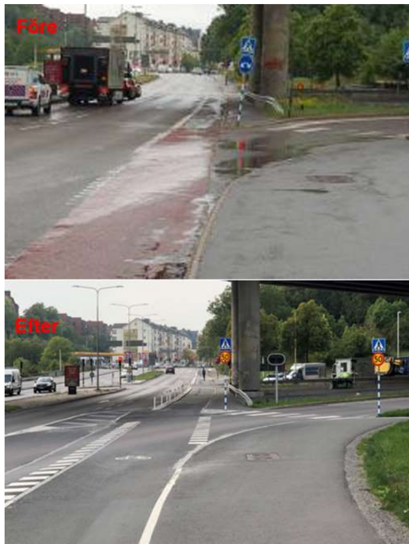
Figur 8. Bild som visar åtgärderna vid Hägerstensvägens norra sida, i höjd med påfartsrampen till Essingeleden. Övre fotot är taget före och nedre fotot efter ombyggnaden. Fotona är tagna i västlig riktning och visar hur gång- och cykelpassagen över påfartsrampen höjts upp samt ny cykelbana som separerats mot körbanan med betongstöd.
