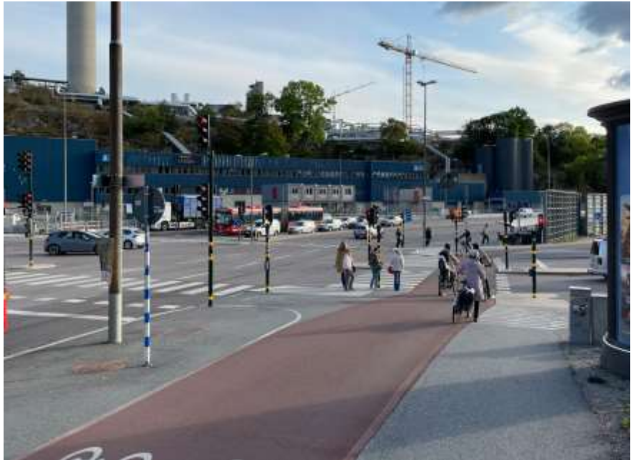
Bild 4. Röd asfalt i korsningen Henriksdalsvägen/Värmdövägen
