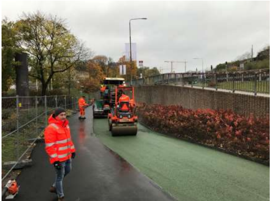
Bild 5. Grön asfalt vältras vid anläggandet 2020
