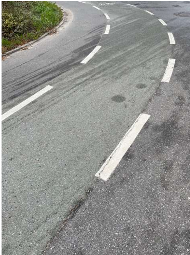
Bild 6. Grön asfalt vid uppföljning oktober 2024
