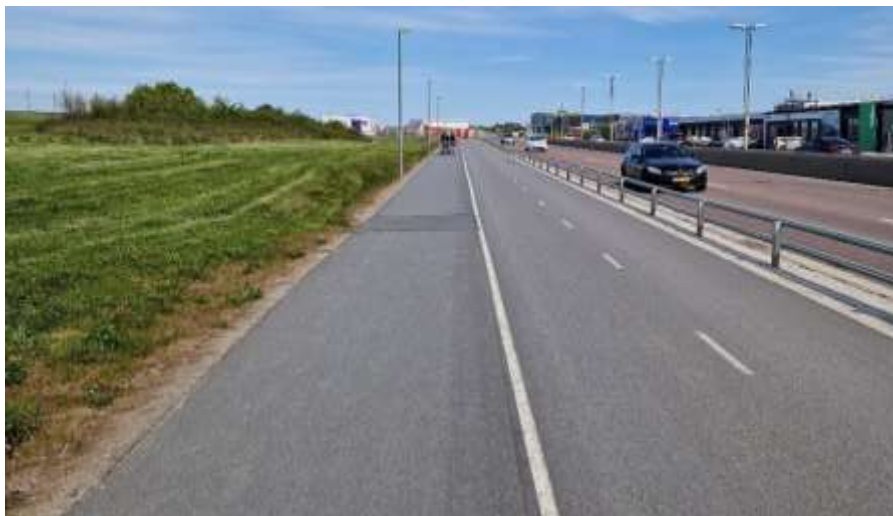
Bild 6. Gång- och cykelbanan längs Ulvsundavägen efter ombyggnationen av delsträcka B. Gång- och cykelbanan har breddats österut mot Ulvsundavägen och ett nytt vägräcke som separerar trafikanterna har satts upp.
