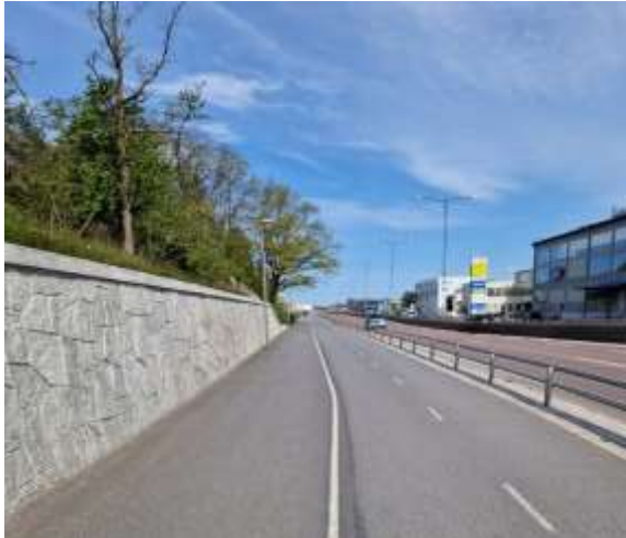
Bild 4. Gång- och cykelbanan efter ombyggnationen, sett från Kvarnbacksvägen. Vänster i bild syns den nyanlagda stödmuren och det nyanlagda vägräcket syns till höger i bild.
