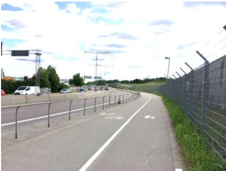
Bild 7. Gång- och cykelbanan innan ombyggnationen, sett söderut från flygplatsinfarten. På vänster sida syns ett äldre vägräcke och på höger sida syns skyddsstängsel vid Bromma flygplats.
