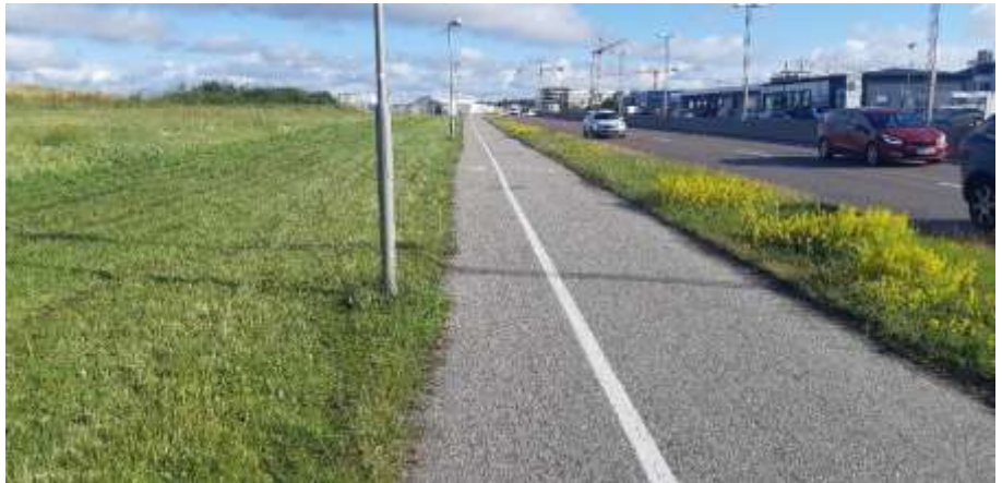
Bild 5. Gång- och cykelbanan längs Ulvsundavägen innan ombyggnationen av delsträcka B.
