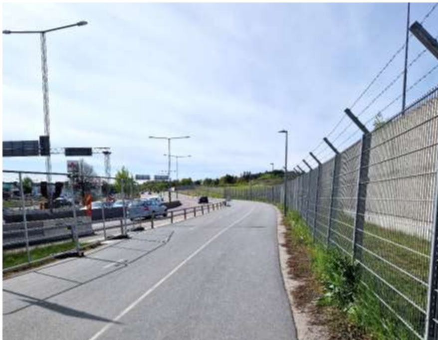
Bild 8. Gång- och cykelbanan efter ombyggnationen, sett söderut från flygplatsinfarten. På vänster sida syns det nya vägräcket och på höger sida syns skyddsstängsel vid Bromma flygplats.
