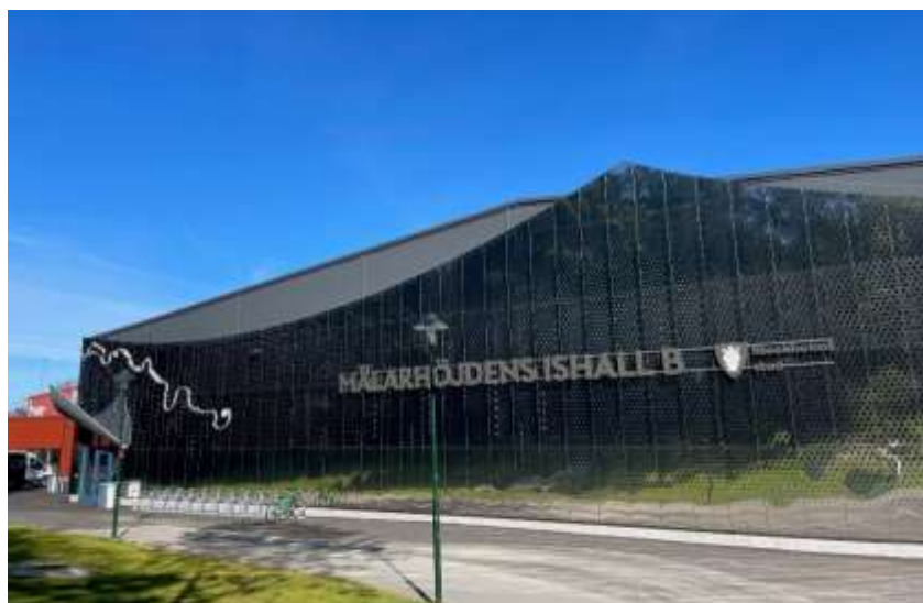
Figur 2: Mälarhöjdens idrottsplats nya ishall. Transporter kan idag enbart nå byggnaden västerifrån.
