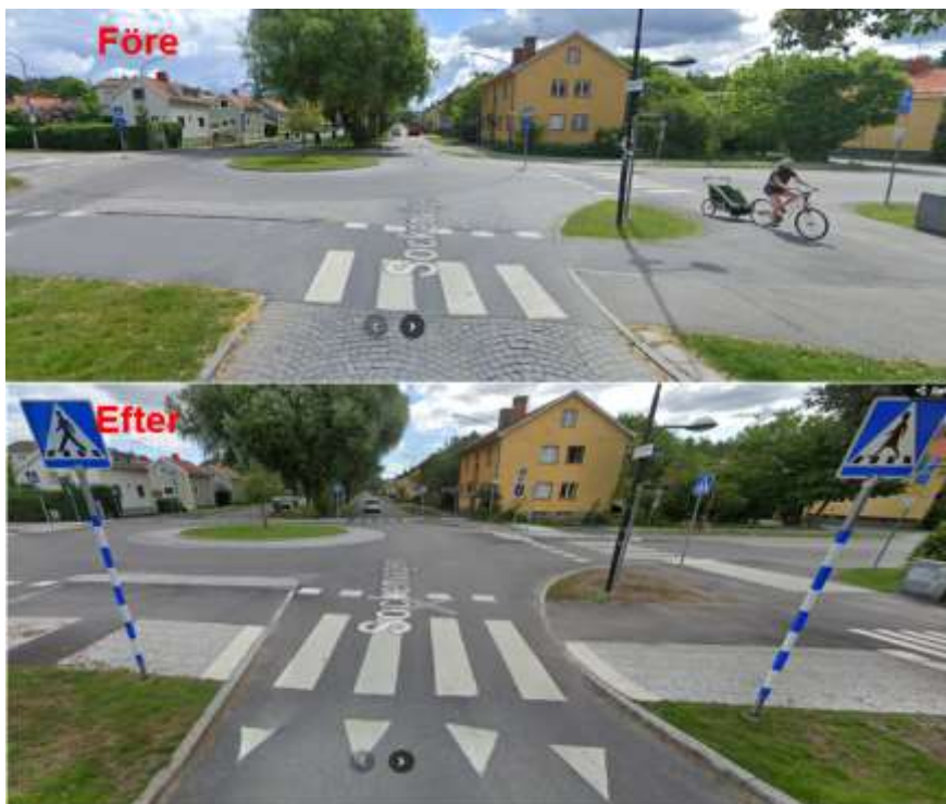
Figur 7. Bild som visar två foton av cirkulationsplatsen vid Handelsvägen före och efter genomförda åtgärder. Övre fotot är taget före och nedre fotot efter ombyggnaden. Fotona är tagna i östlig riktning och visar tillgänglighetsanpassade övergångsställen och att smågatstenen i körbanan avlägsnats. (Källa: Google)
