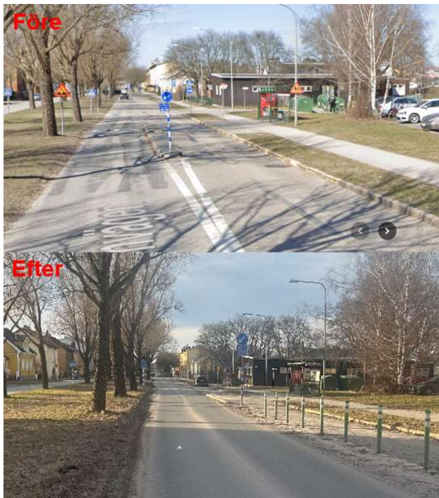
Figur 6. Bild som visar två foton av Sockenvägens norra sida före och efter genomförda åtgärder. Övre fotot är taget före och nedre fotot efter ombyggnaden. Fotona är tagna i västlig riktning och visar den ombyggda busshållplatsen mellan Stockholmsvägen och Mellanvägen. (Källa: Google)
