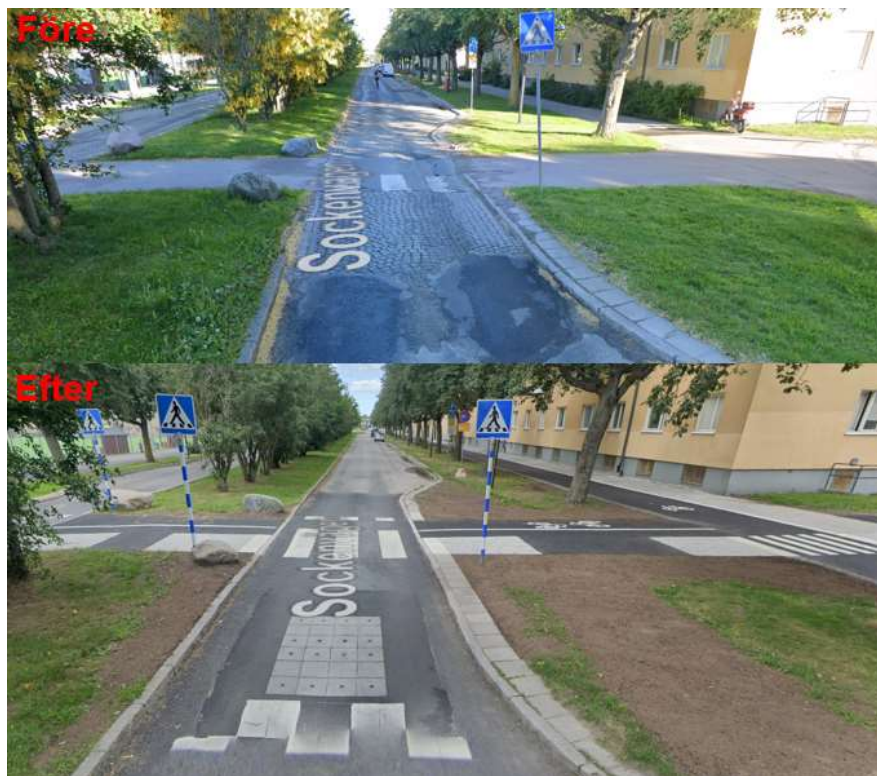
Figur 8. Bild som visar två foton av övergångsställe mellan Handelsvägen och Enskedevägen före och efter genomförda åtgärder. Övre fotot är taget före och nedre fotot efter ombyggnaden. Fotona är tagna i västlig riktning och visar tillgänglighetsanpassade övergångsställen och nya hastighetsdämpande åtgärd.
