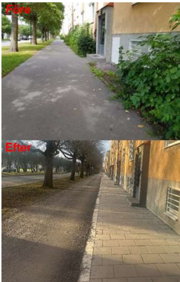
Figur 9. Bild som visar två foton av gång- och cykelvägen väster om Handelsvägen före och efter genomförda åtgärder. Övre fotot är taget före och nedre fotot efter ombyggnaden. Fotona är tagna i västlig riktning och visar den nya separerade gång- och cykelbanan norr om Sockenvägen.
