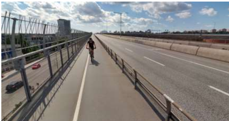
Figur 4. Fotografi som visar Skanstullsbrons östra gång- och cykelbana i riktning söderut, före ombyggnation. Gångbanans bredd är 1,3 meter och cykelbanas 2 meter.
