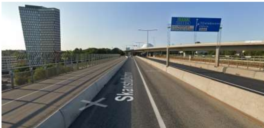
Figur 7. Fotografi som visar Skanstullsbrons östra körbana i riktning söderut, efter ombyggnation. Körbanan är uppdelad i två något breddade körfält, varav ett för kollektivtrafik.
