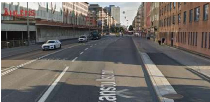
Figur 9. Fotografi som visar sträckan norr om Skanstullsbron mot Ringvägen, efter ombyggnad. De två körfälten från bron breddar upp till tre vid korsningen med Ringvägen. Angöring till fastigheter är kvar.
