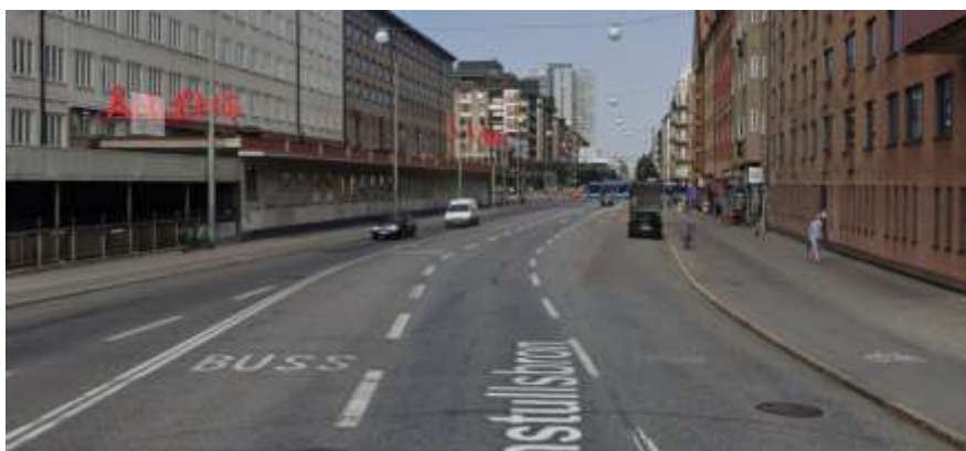
Figur 8. Fotografi som visar sträckan norr om Skanstullsbron mot Ringvägen, före ombyggnad. De tre körfälten från bron fortsätter förbi angöring till fastigheter.
