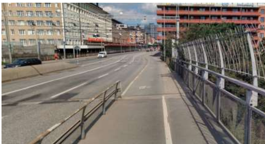
Figur 2. Fotografi som visar Skanstullsbrons östra gång- och cykelbana i riktning norrut, före ombyggnation. Gångbana har en bredd om 1,3 meter och cykelbana 2 meter.
