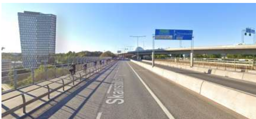
Figur 6. Fotografi som visar Skanstullsbrons östra körbana i riktning söderut, före ombyggnation. Körbanan är uppdelad i tre körfält, varav ett för kollektivtrafik.
