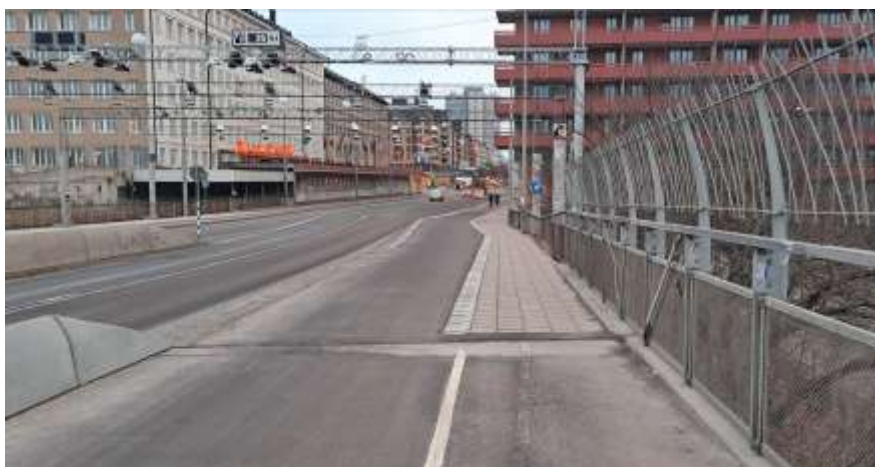
Figur 3. Fotografi som visar Skanstullsbrons östra gång- och cykelbana i riktning norrut, efter ombyggnation. Gångbana har breddats till 2 meter och cykelbana till 3,25 meter.
