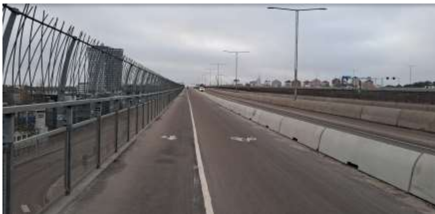
Figur 5. Fotografi som visar Skanstullsbrons östra gång- och cykelbana i riktning söderut, efter ombyggnation. Gångbanans bredd är 2,2 meter och cykelbanans 3,25 meter, cyklister separeras från fordonstrafiken med barriärelement.
