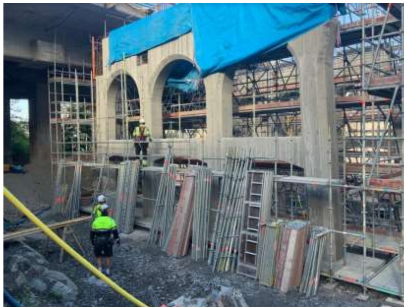
Bild 2: Foto som visar pågående betongarbeten på nya brostöd på östra sidan av kanalen.
