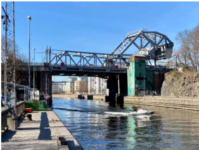
Bild 1: Foto på Norra Danviksbron, sedd norrifrån, före påbörjad renovering.
