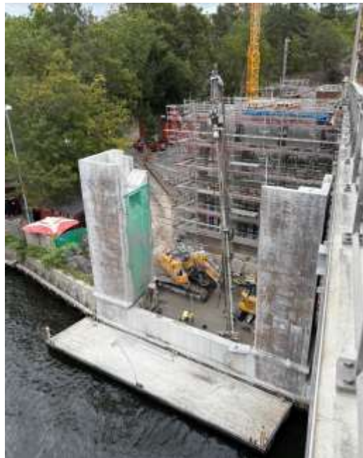
Bild 3: Foto som visar pågående entreprenadarbeten på östra landfästet med befintliga och nya betongkonstruktioner.
