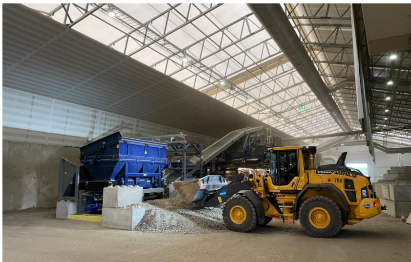
Bild 4 Sorteringsanläggningen på MLC med inlastning av schaktmassor i kupan.
