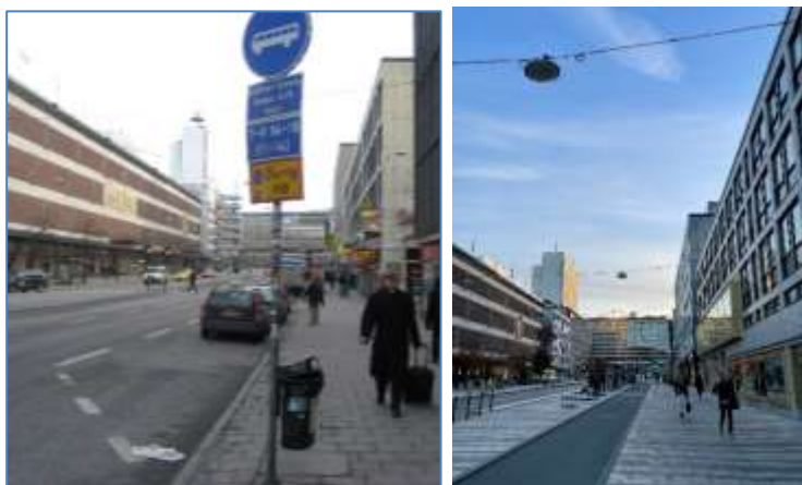
Klarabergsgatan före och efter ombyggnad
