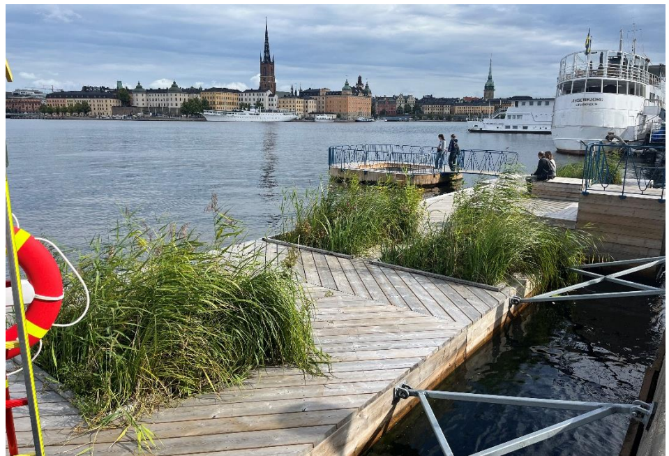
Figur 19. Kajbalkong vid Söder Mälarstrand, Riddarfjärden. Vegetationstråg utgör en del av trädäcket. I mitten av trädäcket finns utrymme för att sänka ner julgranar. Ytan uppskattas även av mänskliga besökare. Foto: Katarina Forslöw.
