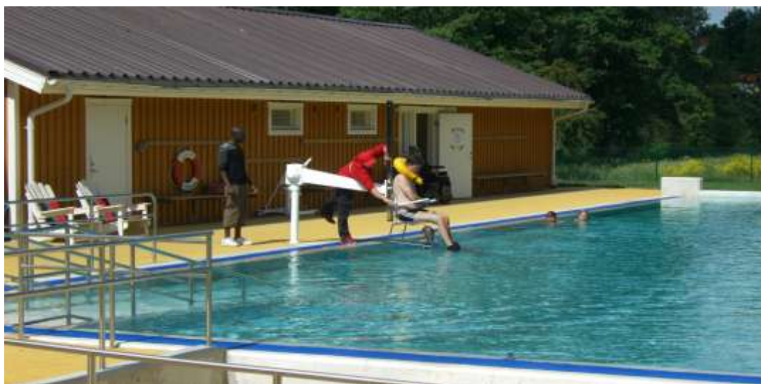
Den upprustade bassängen och omklädningsbyggnaden
