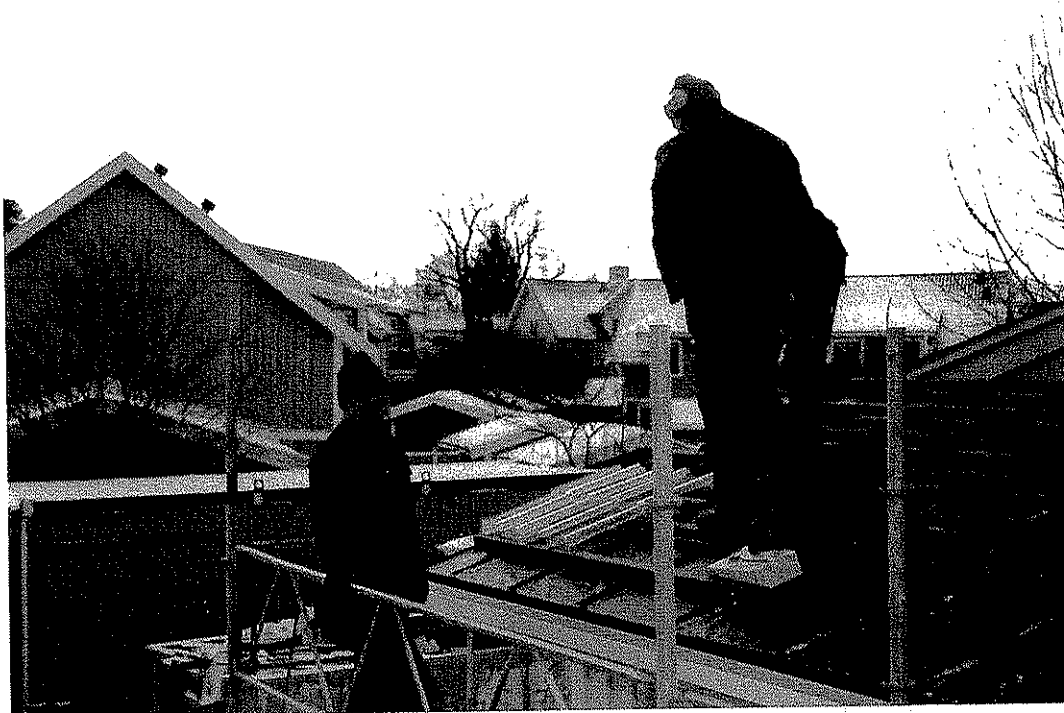
De ombyggda lokalerna för förskolan Matrisen försågs med ett helt nytt uppvärmningssystem. Här läggs takpannor av glas för en ny typ av solfångare.
