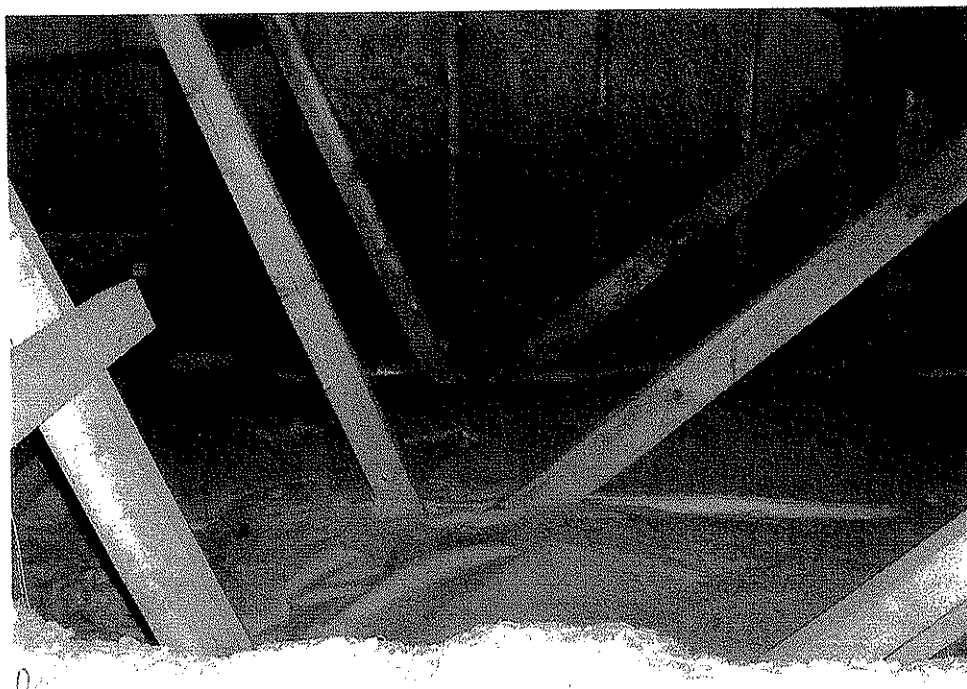
14 förskolevindar isolerades med lösull. Bilden visar vinden med isolermattor innan lösullen sprutas in.
