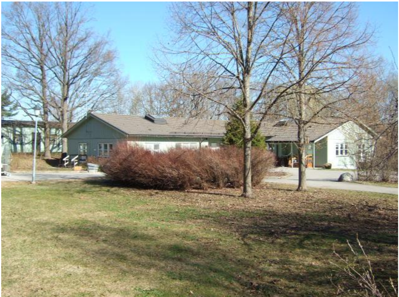
Bild på byggnaden sett från vägen och P-platsen
