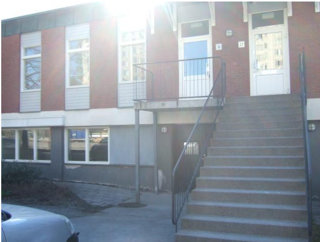
Bild 1 visar baksidan av huset med nödutgång
