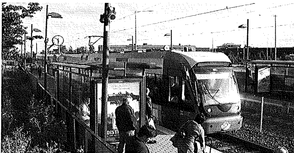
Figur 25 Tvärbanan station Årstaberget. Foto: PG Andersson
