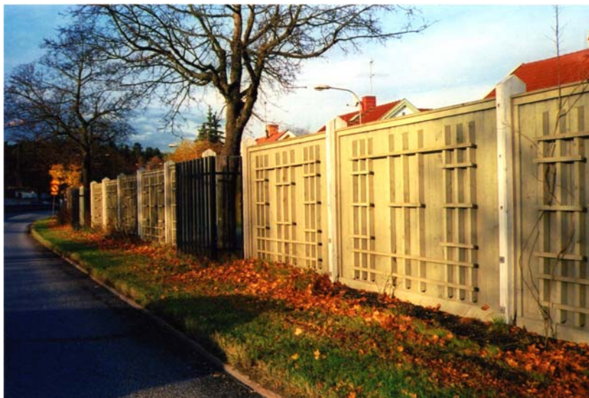
Figur 6. Skärm längs Bergslagsvägen med sina karaktäristiska ljusöppningar vid träden.
