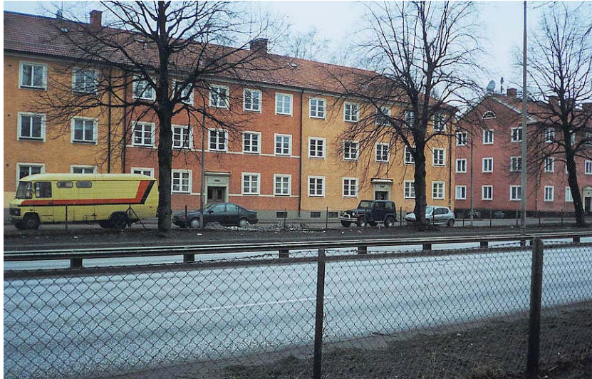
Figur 4. Byggnader vid Nynäsvägen med ljudisolerande fönster
