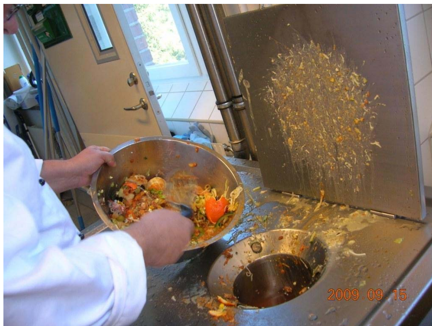
Inkast till Envac MicroVac i Blackebergs gymnasium
