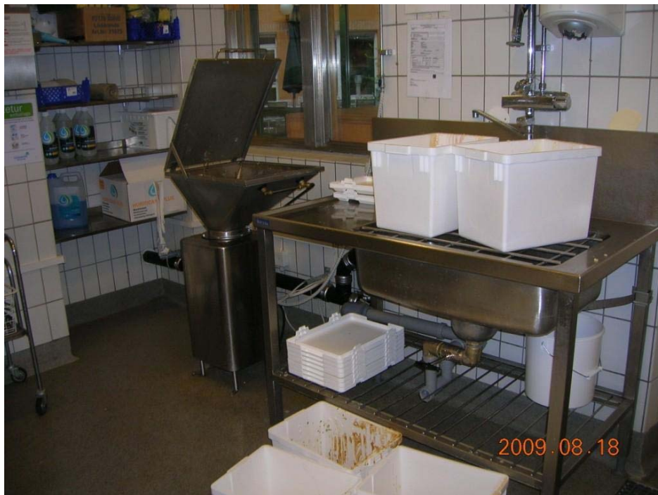
Kvarn Uson Local Macerator i diskrummet på Stockholms Sjukhem
