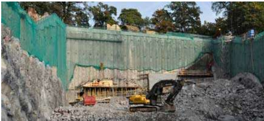
Under Bellevuekullen pågår arbetet med betongtunnelns anslutning till bergtunneln.
