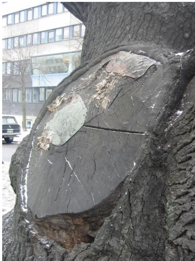
Beskärnings- och rötskada 2003
